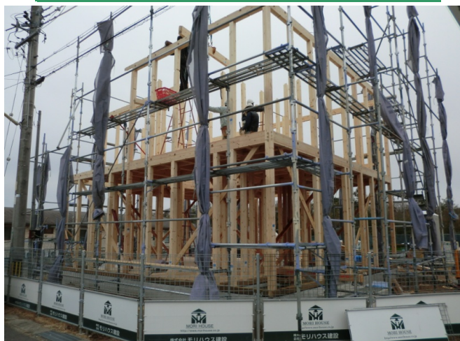
二階部分の建て方。
