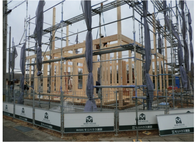
二階の土台(梁)の固定作業
