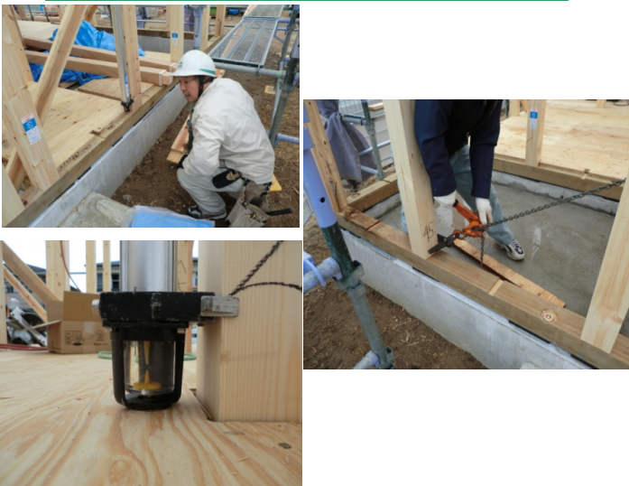
プレカット材の組立風景
