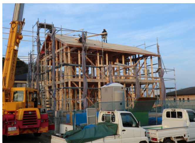
⑫野地板を葺いて本日終了。
