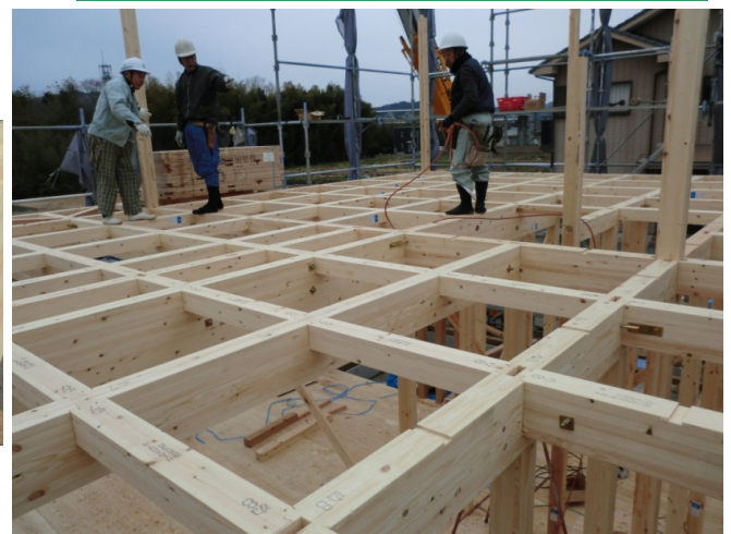
二階の土台(梁)の固定作業
