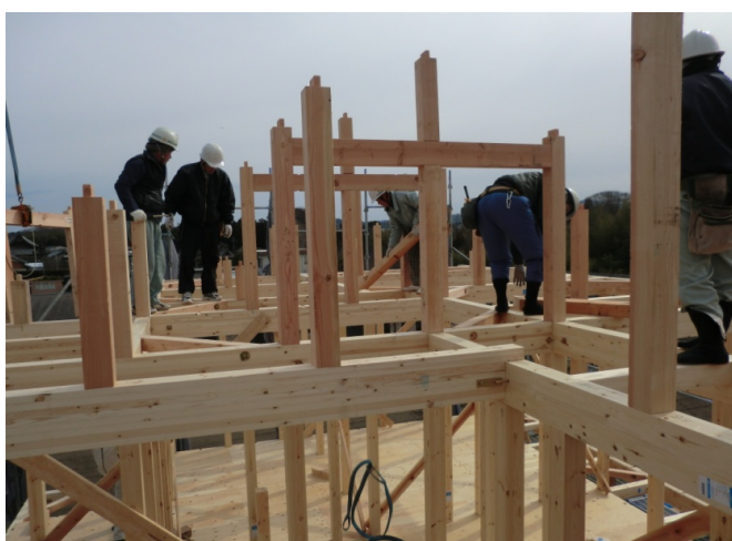
小屋組みの準備が進みます。
