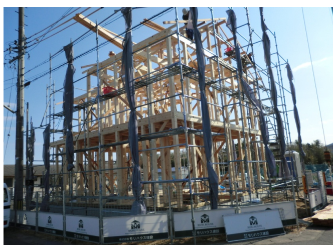
小屋組み工程。
