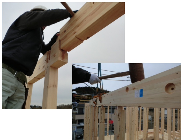
プレカット材の組立風景
