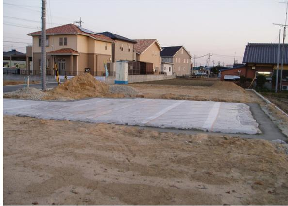
まず、地盤に砕石などを点圧し、基礎の下地となる地盤の工事をおこないます。外周部には捨てコンクリートを施工し、点圧地盤には防湿シートを施工し、地下からの防湿を行います。
