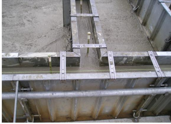
ポンプ車により立ち上がり部分からコンクリートを打設し、そしてベース部分を打設します。一回の工程で打設するので時間的なロスも無く、しかも打ち継ぎの無い丈夫な鉄筋コンクリートべた基礎が完成します。この後、シートを被せ養生期間を経て、レベラーを流し込み脱枠すると…………
