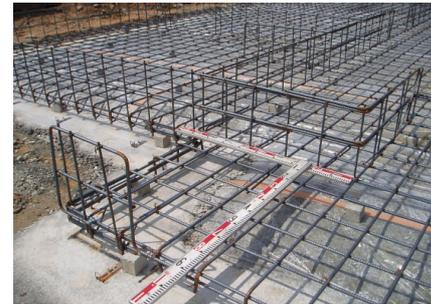
10 と13 の異型鉄筋(メッシュバー)を150mmの升目格子に配筋を行います。(基礎立ち上がりの横筋のピッチは200mmです。)
