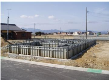
精度の高いメタルフォーム型枠が専門の職人の手により組み立てられていきます。
