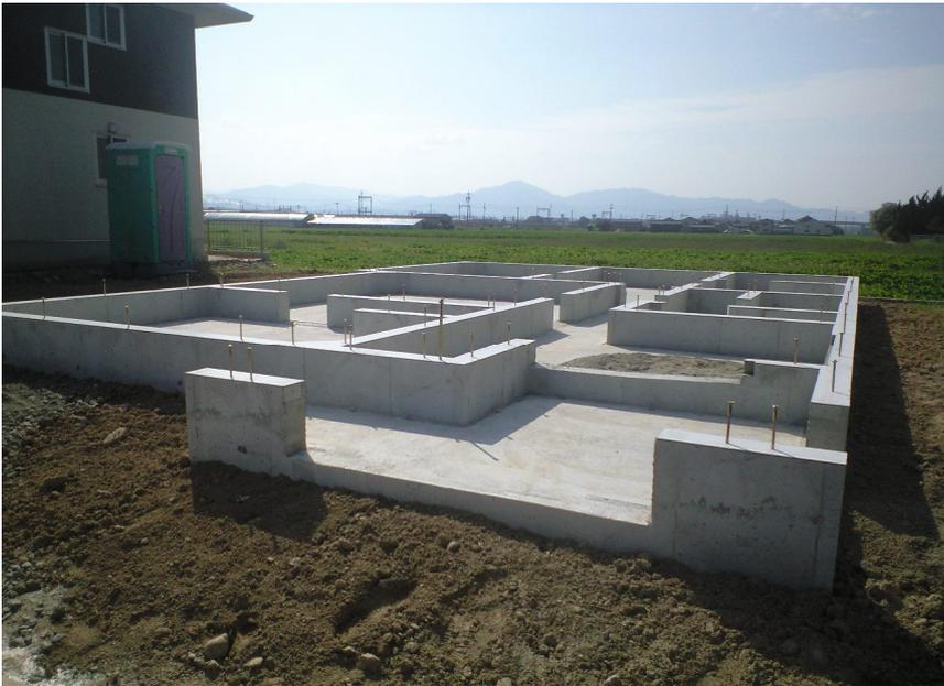
メタルフォーム型枠を脱枠すると、きれいな基礎面が出てきます。もちろん見た目だけではなく、強度・精度ともに二度打ちの基礎を上回っています。また、重要なコーナー部分は補強仕様となっています。安心の基礎構造です。
